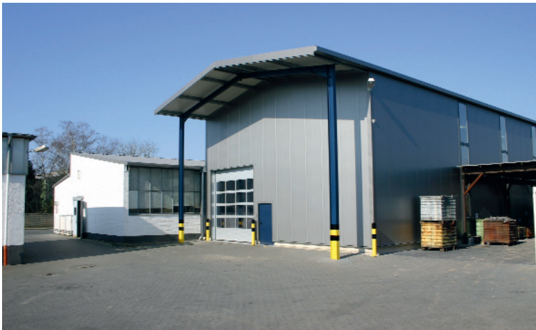
Bild 2 Neubau erweitert Lagerkapazitäten
